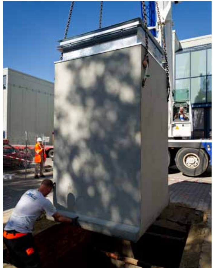
Ab unter die Erde: Die Unterflursysteme der BSR zur Abfallentsorgung. Foto: BSR
