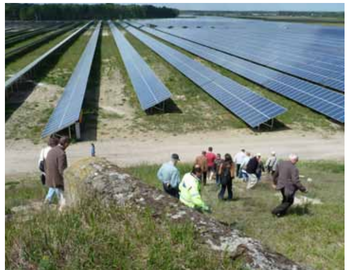
Besuch beim fünftgrößten deutschen Solarstrom-Kraftwerk FinowTower. Foto: Klaus Völker
