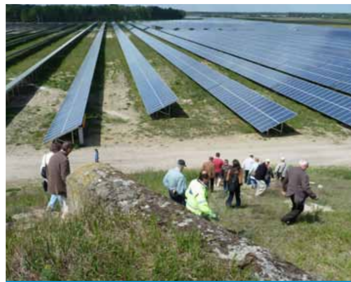
Besuch beim fünftgrößten deutschen Solarstrom-Kraftwerk FinowTower. Foto: Klaus Völker
