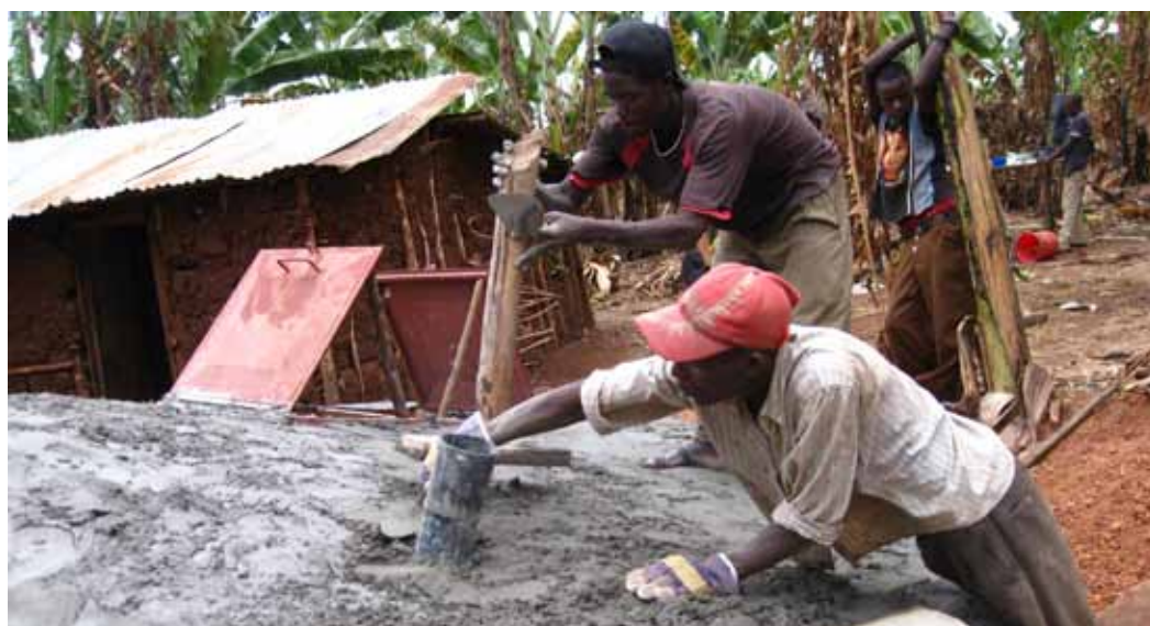
Ein Projekt der Regionalgruppe Berlin der „Ingenieure ohne Grenzen“ heißt Wassertanks für Tansania. Hier wird gerade das Dach des zweiten 40.000 Liter Tanks auf Chonyonyo fertig gestellt. Foto: Ingenieure ohne Grenzen
