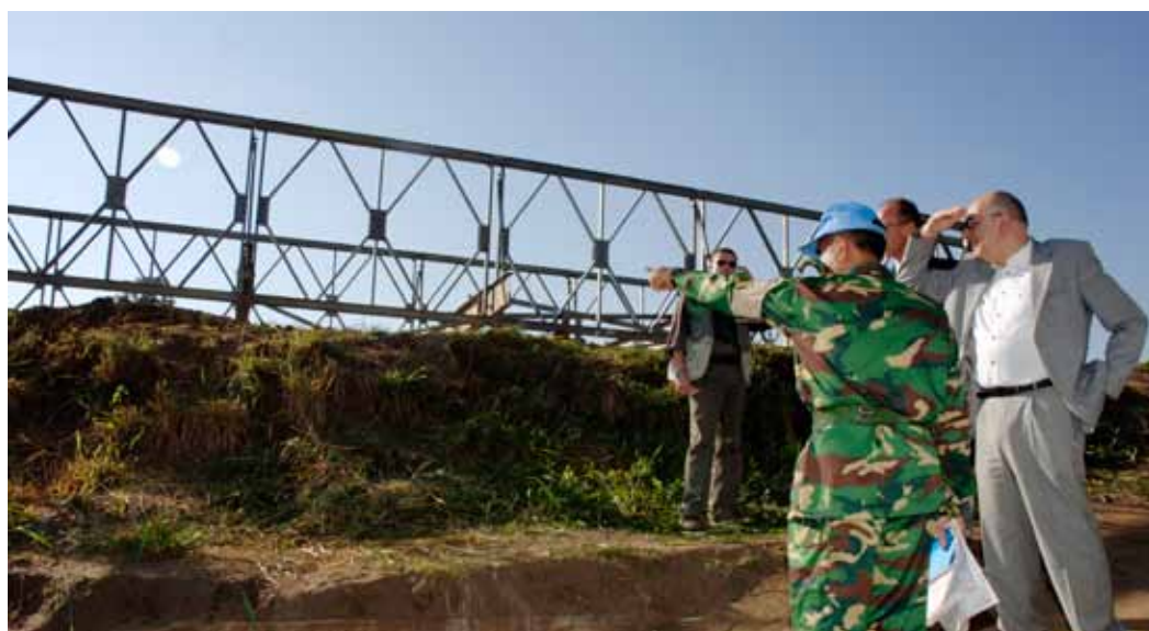
Ein UN-Repräsentant besichtigt eine Brücke im Sudan, die Friedensfachkräfte gebaut haben. Foto: UN/Arpan Munier
